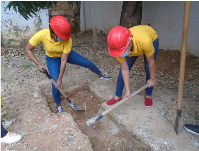
Zanja para colocar armadura de acero
