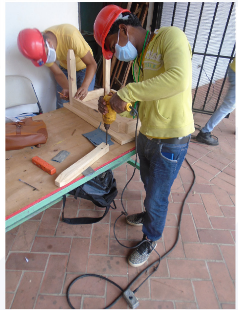
Construcción de mesa
