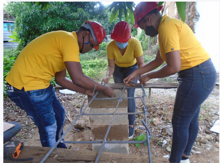
Armadura de acero en zapata y columnas
