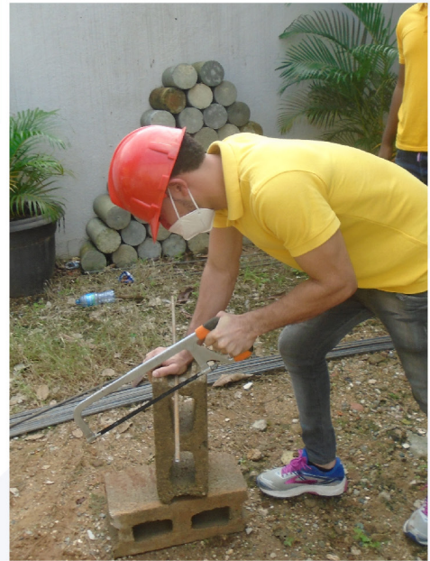
Corte de barras de acero
